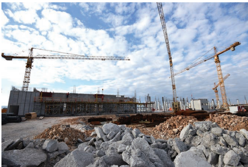
Detalj s gradilišta
