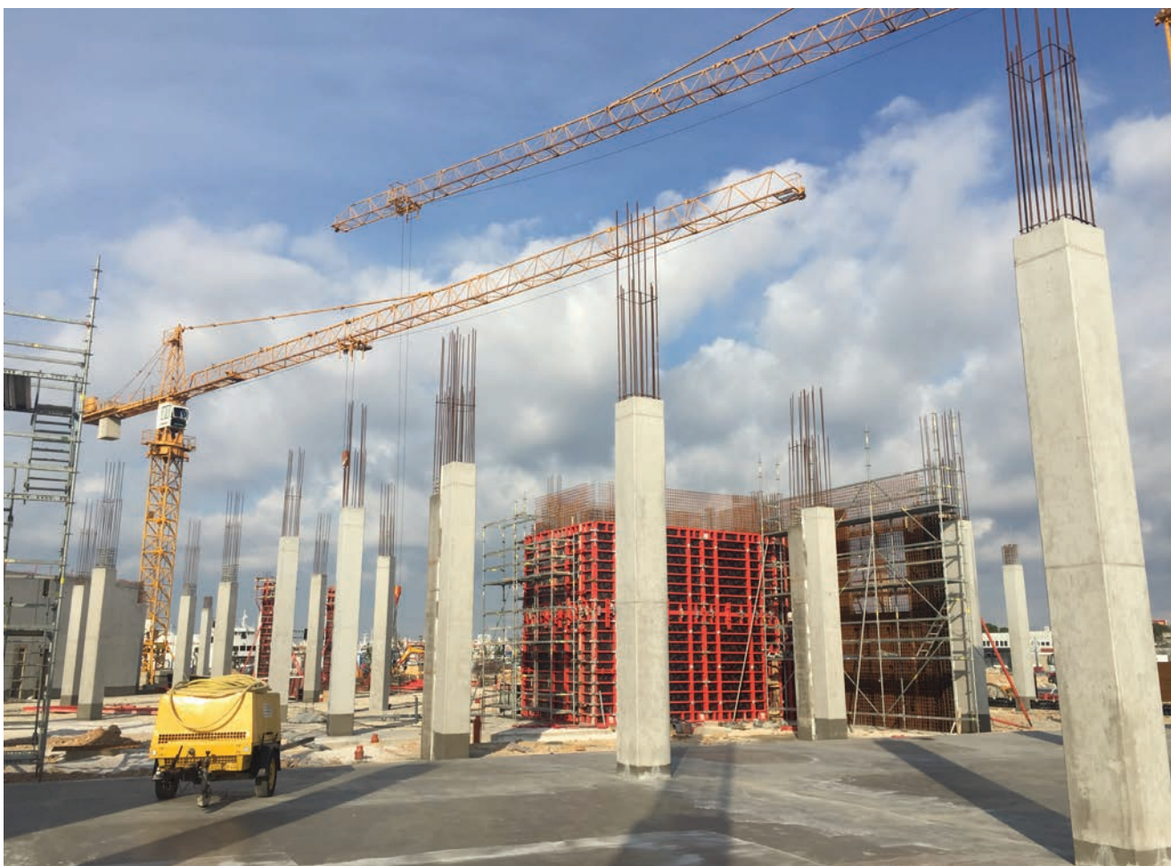
Izvedba stupova prizemlja
