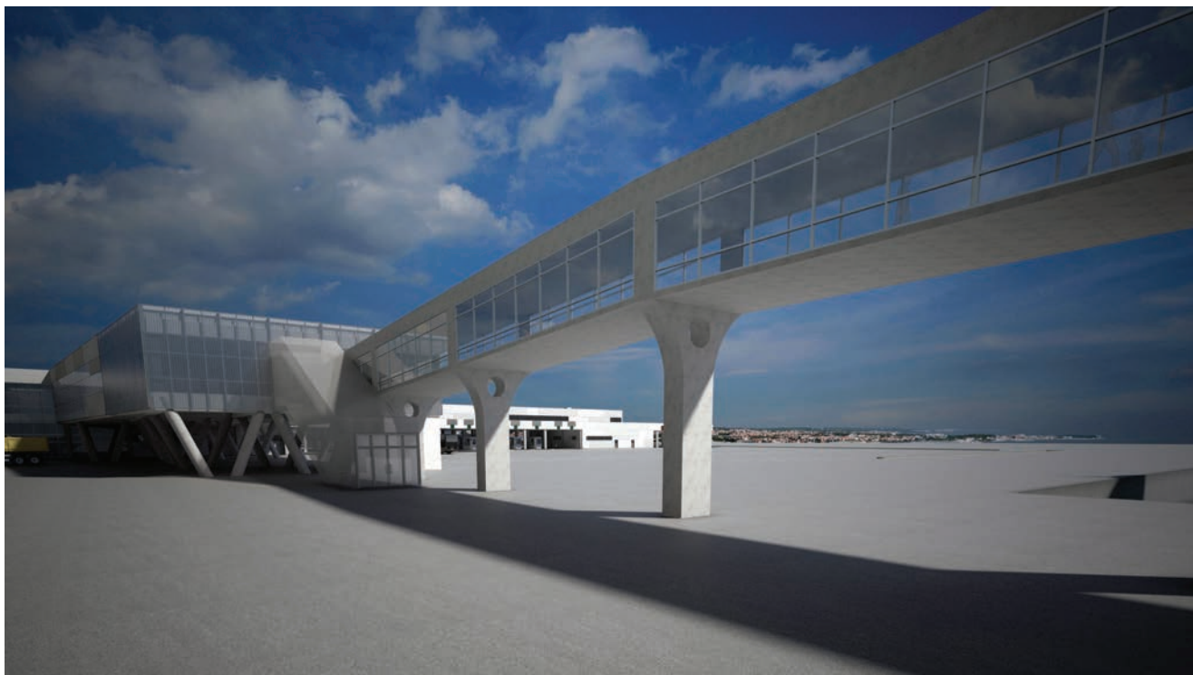
Prikaz mosta prema pristanu brodova na kružnim putovanjima
