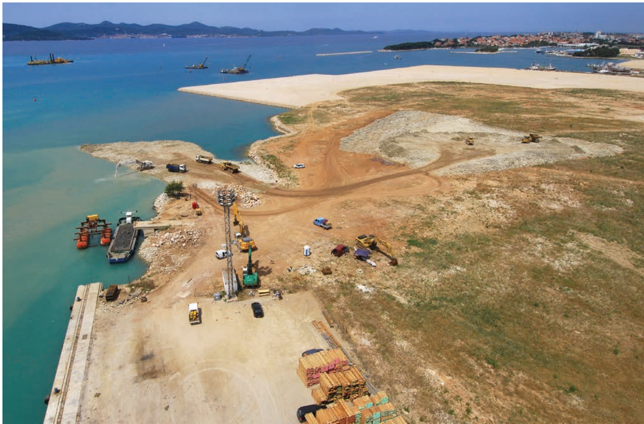
Nasipavanje materijala tijekom prve faze projekta
